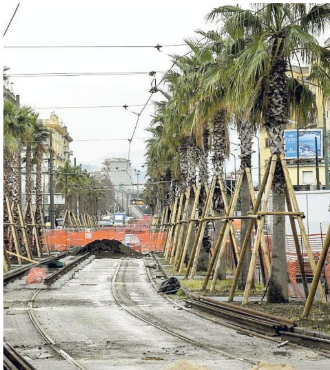
I lavori di rifacimento di via Marina
